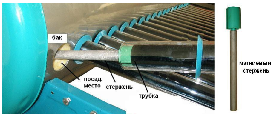
Рис. 4 Способ установки магниевого стержня
